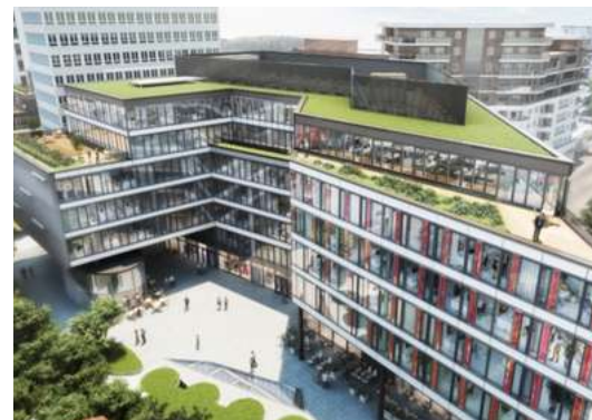
Mogilska 35 Office gotowy latem 2023 r.
